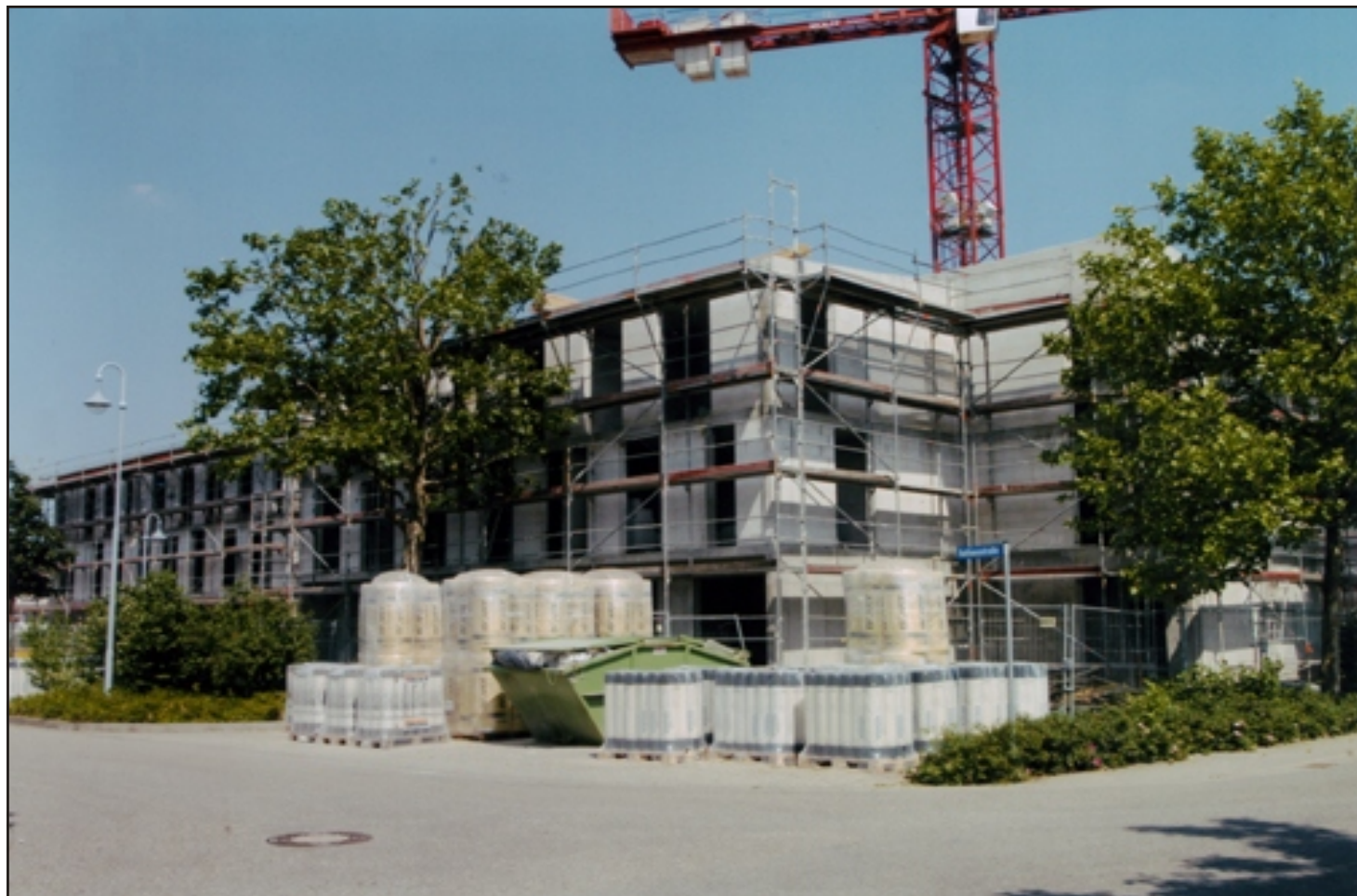
Am Seniorenzentrum in St. Leon-Rot wurde gestern Nachmittag Richtfest gefeiert: Für 9,5 Millionen Euro entstehen ein Altenpflegeheim und Eine Wohnanlage für betreutes Wohnen. Im März 2007 sollen die Gebäude bezugsfertig sein. Foto: Heinzmann
